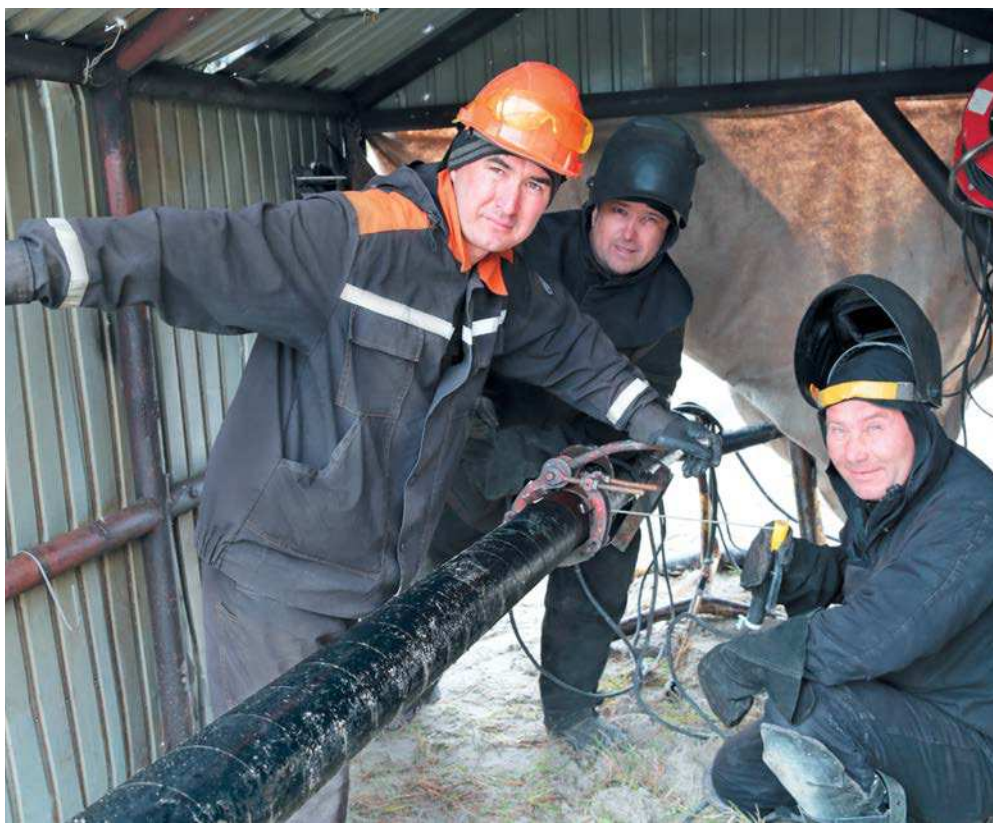
Монтажники подготавливают трубу под сварку в установленной палатке
