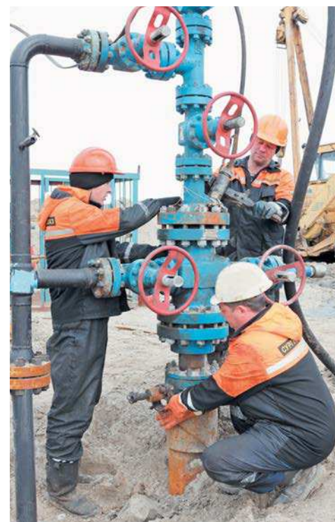
«Ершовские» бригады по освоению (испытанию) скважин быстро подтвердили статус передовиков производства
